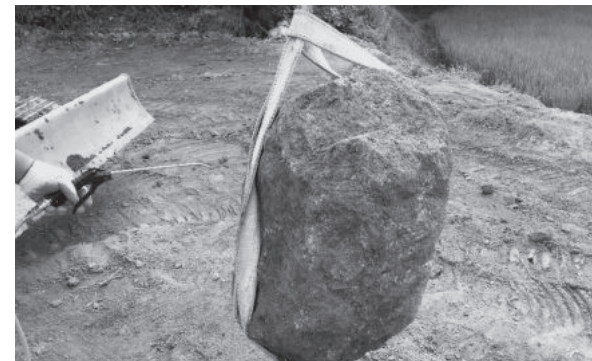
사진 7. 고압의 공기를 이용한 표면 세척
