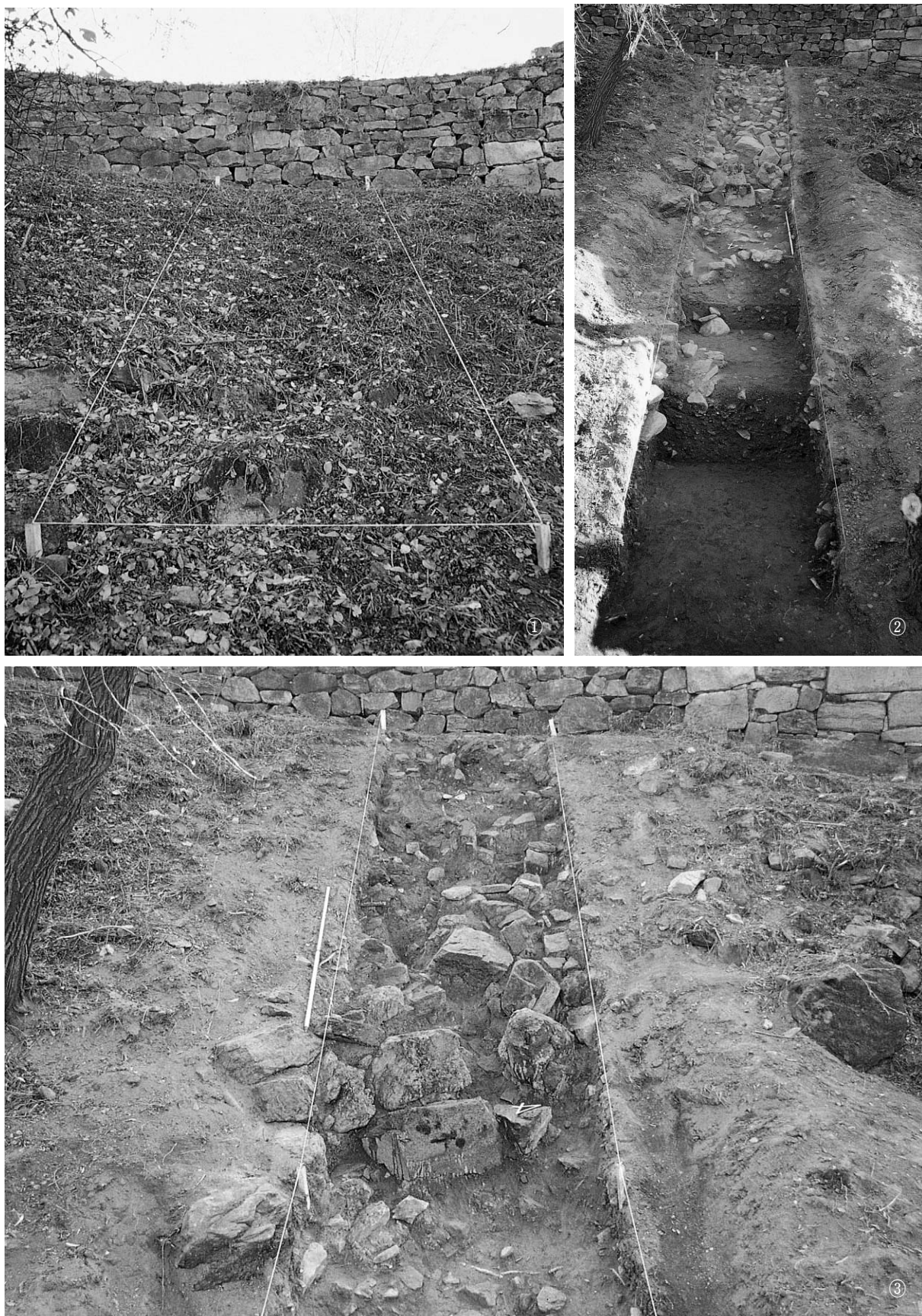
사진 5. 성벽 32+15 ① 발굴 전 전경, ②, ③ 발굴 후 전경
