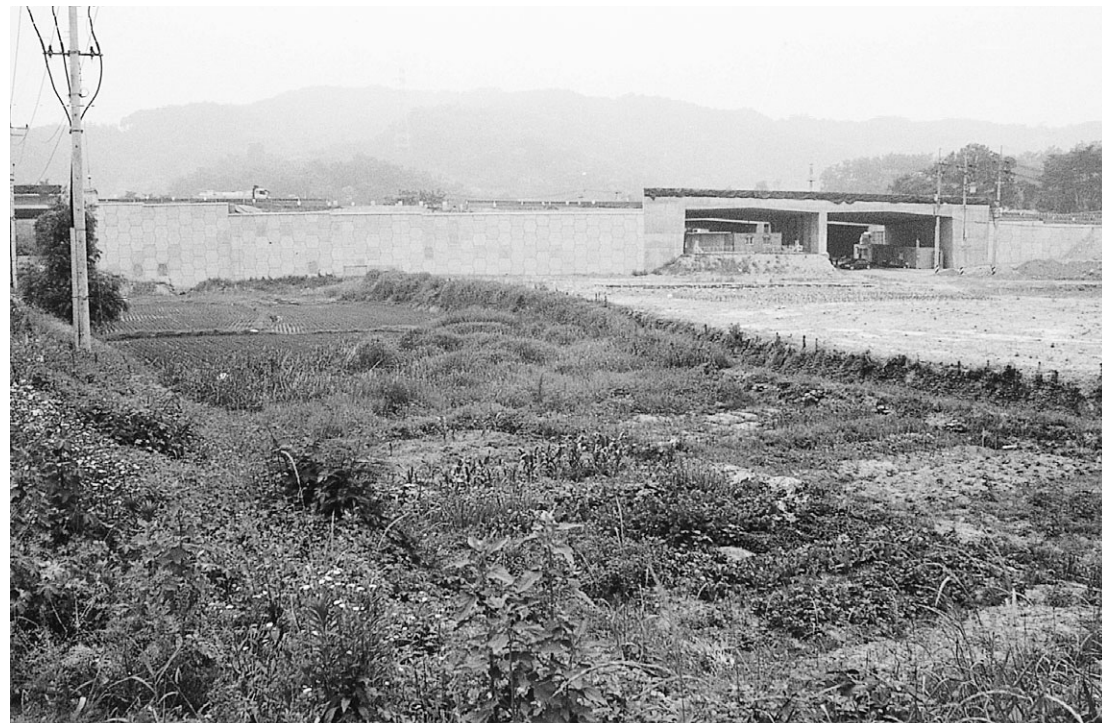
사진 6. II 區間 全景(1)(東→西)
