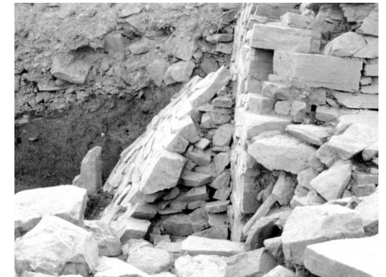
성산산성 남문지 외벽 기단보축
